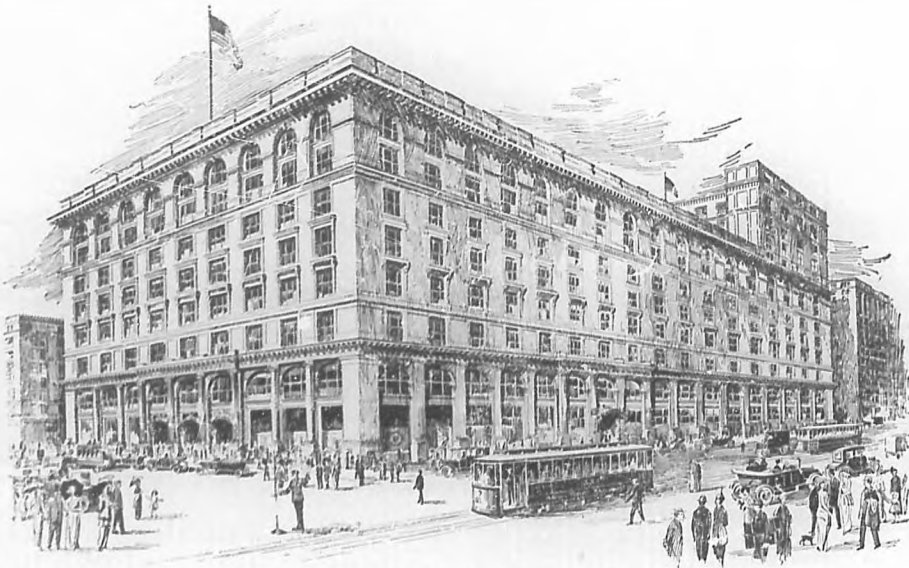
EDIFICIO PROPIO QUE OCUPA UNA MANZANA ENTERA.
